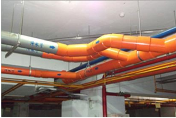
桃園 BOT 系統用戶接管工程 大樓地下室改管
