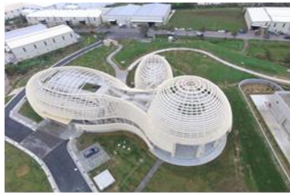
桃園北區系統水資源回收中心
