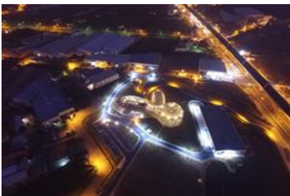
桃園北區系統水資源回收中心
