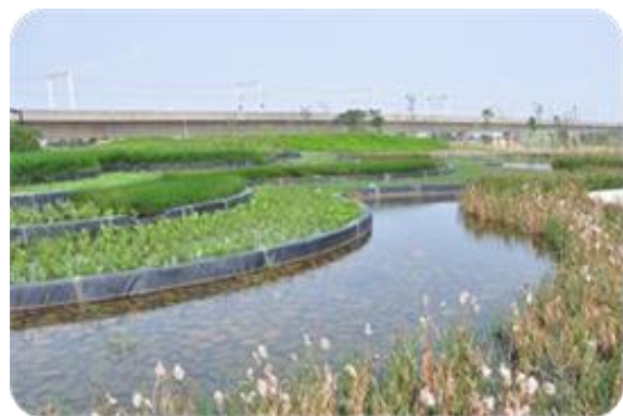
桃園北區系統水資源回收中心
