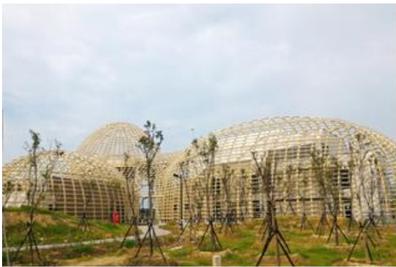
桃園北區系統水資源回收中心
