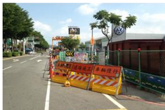
桃園 BOT 系統桃園區經國路推進工程 施工佈設
